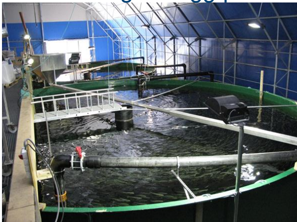
Resirkuleringsanlegg på land
